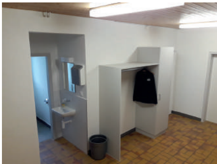
Umbau Klingenberg (URM)
